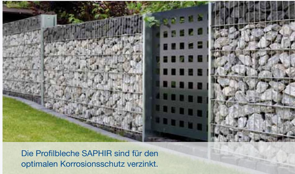
Die Profilbleche SAPHIR sind für den optimalen Korrosionsschutz verzinkt.
